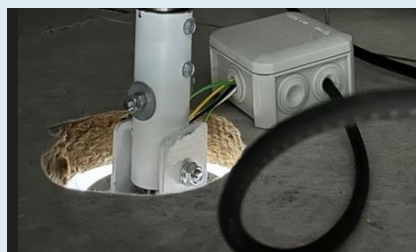
Trou à la scie cloche dans faux plafond
