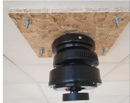
**NOTE IMPORTANTE :** bien vérifier l'horizontalité du support de plafond (platine) par rapport au plafond (niveau à bulles) avant de fixer le moteur.
