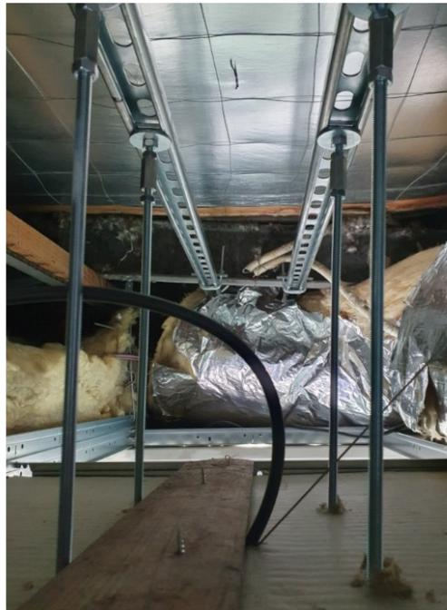
Autre solution avec une fixation directe sur poutre métallique traversante
